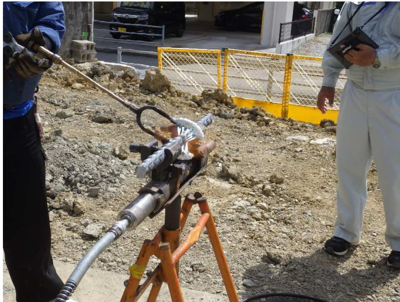
ガス圧接継手検査 （鉄筋同士をガスで繋げる手法の確認）
