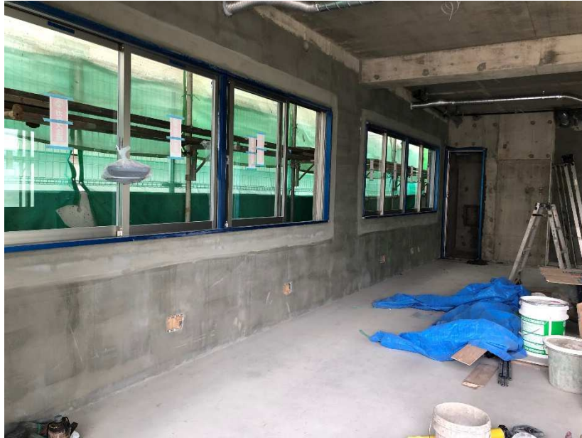
鋼製建具取り付け
