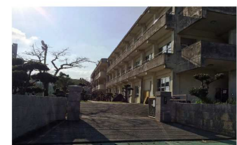
■現況、校門（裏門）周辺、改修建物
