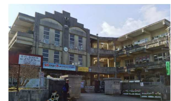
■現況、校門（正門）周辺、解体建物
