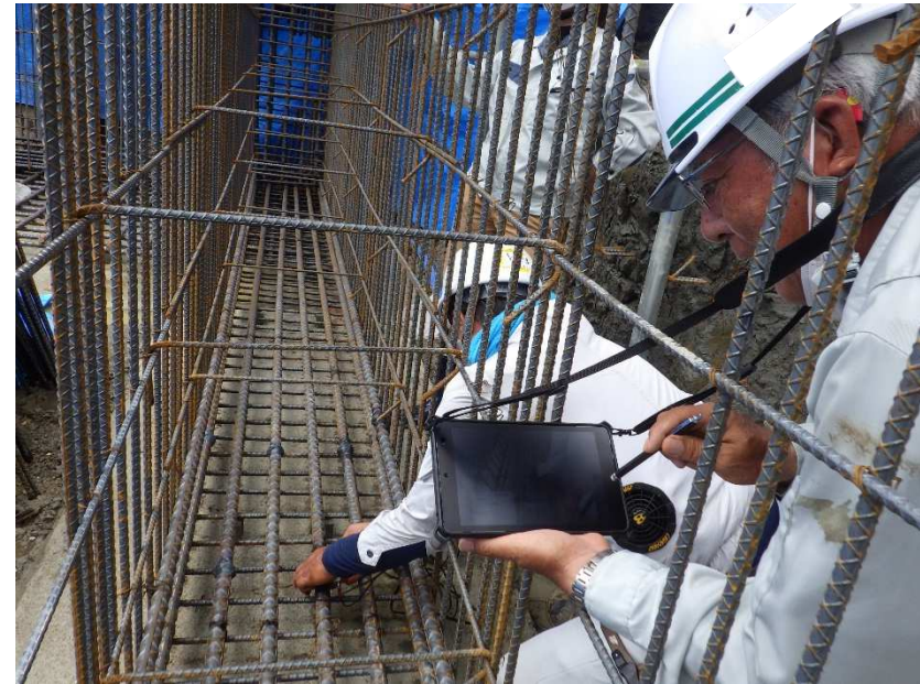
配筋検査 （鉄筋が正確に組まれているかの確認）
