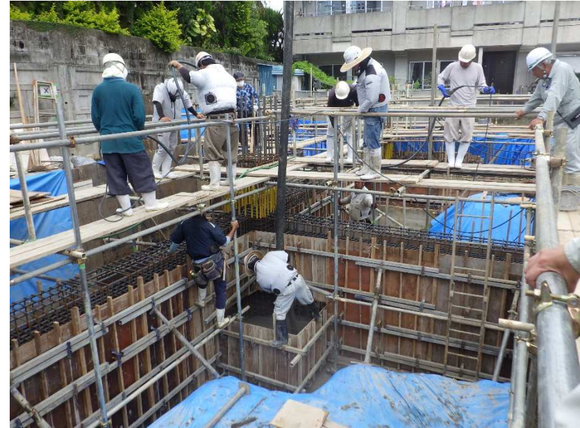
コンクリート打設（基礎）
