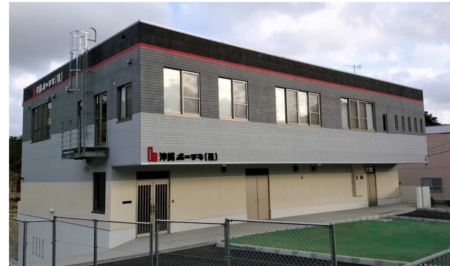
▲沖縄ホーチキ(株)社屋移転新築工事
