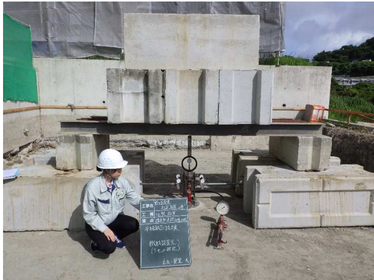
平板載荷試験（地盤の体力度試験）
